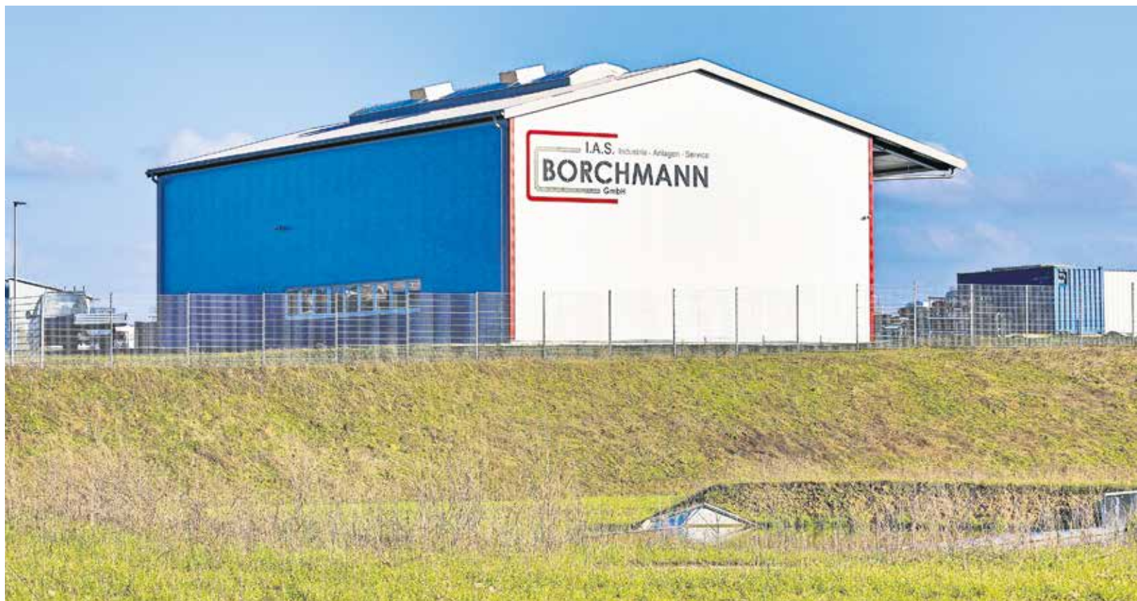
Aushängeschild: Die neue Halle der Firma Borchmann ist schon von weit her gut sichtbar.
